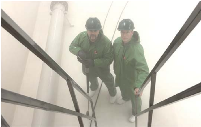
von links: Die Mitarbeiter Frank Wurth und Martin Schneckenburger bei den Reinigungsarbeiten.
