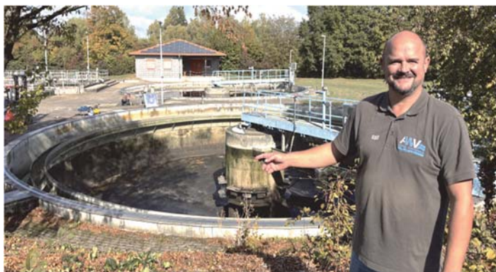
Der Technische Leiter vor dem leeren Nachklärbecken.
