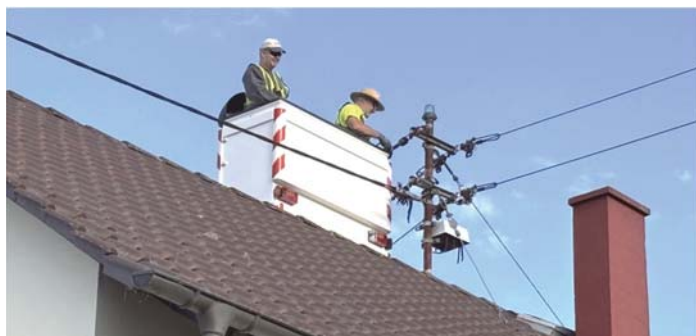
Die Mitarbeiter Jürgen Huser u. Joachim Götz arbeiten an den Freileitungen
