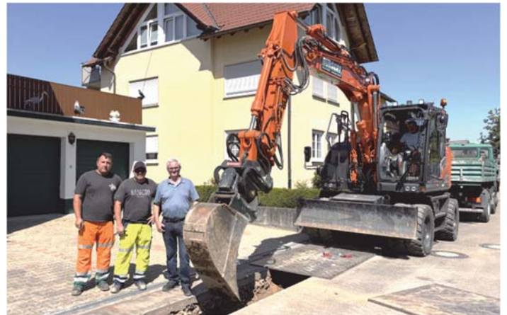
Von links: ein Mitarbeiter der Fa. Burgert sowie Frank Wurth und Thomas Wurth von den Gemeindewerken
