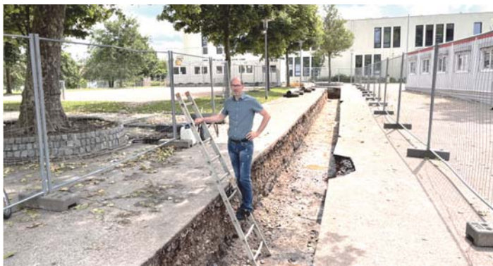
Bauamtsleiter René Wienhold inspiziert den Graben
