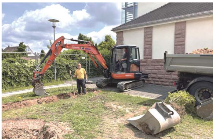
Mitarbeiter der Firma Ritter bei der Arbeit.
